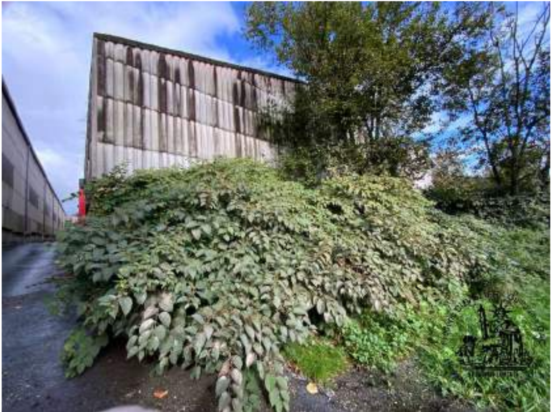
Mur pignon droit du bâtiment B :
