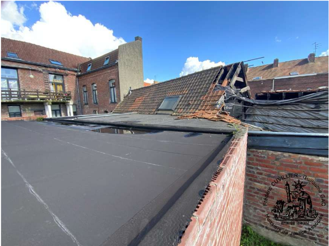
Vue de la toiture effondrée de la seconde partie du lot 11 :
