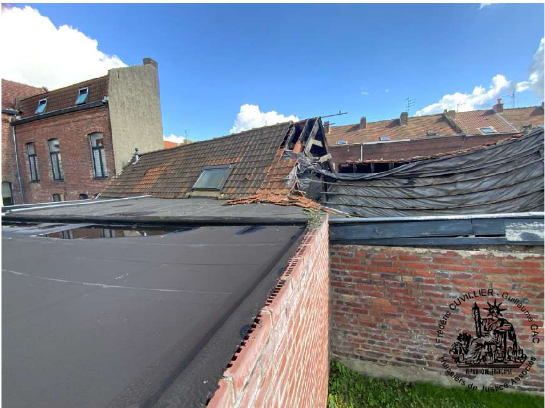
Vue de la toiture effondrée de la seconde partie du lot 11 :
