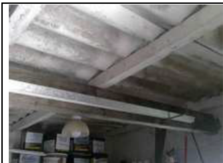
Photo n° PhA001 Localisation : Garage; Atelier Ouvrage : 1 - Couvertures, Toitures, Terrasses et étanchéités - Plaques ondulées et planes Partie d'ouvrage : Plaques en fibres-ciment (y compris plaques « sous tuiles ») Description : Plaques en fibres-ciment (y compris plaques « sous tuiles »)
