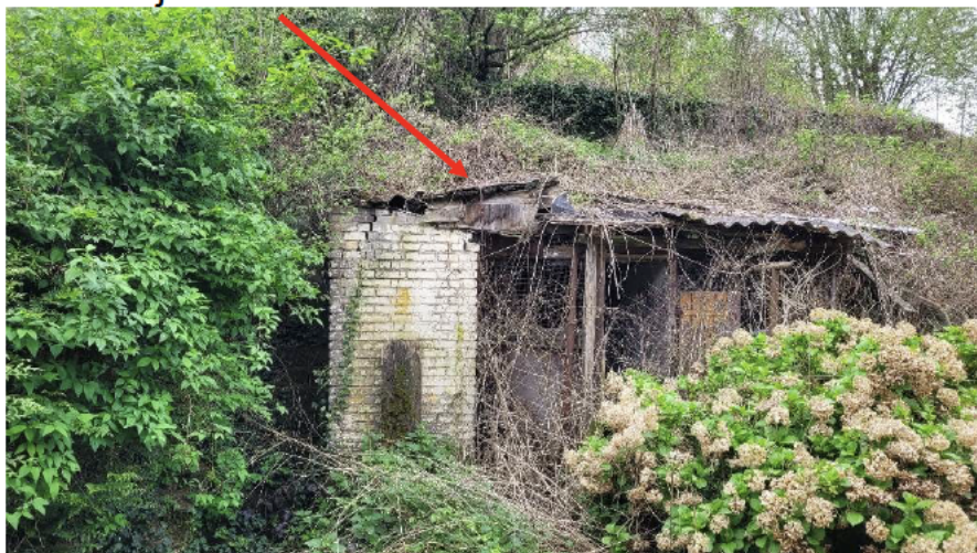
Remise jardin : tôles en fibrociment
