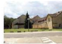
Vue extérieure de la ferme du Manet.
